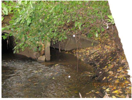
1. North Culvert 1.JPG
