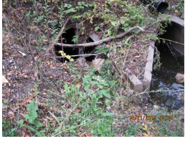
6. South Culvert 1.JPG
