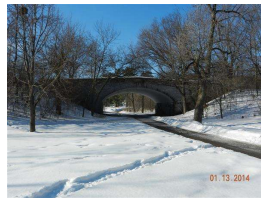
2. 2014 Elevation view 021.JPG
