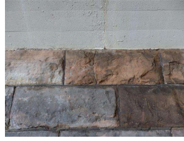
7. N Abutment (1).JPG
