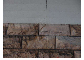
10. S Abutment (1).JPG
