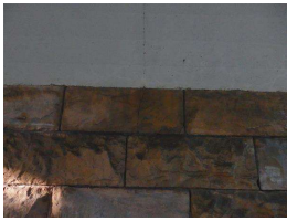
11. S Abutment (2).JPG
