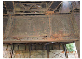
20. pier cap - W.side N.inside bay_1.JPG
