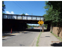
4. NB signage 012.JPG
