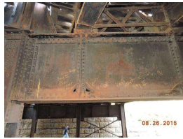
17. pier cap - E.side N.inside bay_1.JPG
