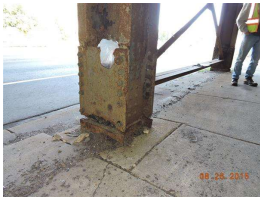
11. E.side - N.inside column - zoom2.JPG
