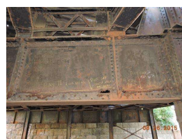
34. pier cap - W.side N.inside bay_1.JPG
