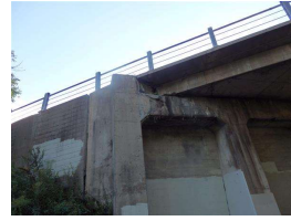
14. Top of N abut, W end.JPG
