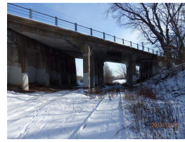
4. 2013 Elevation view 003.JPG
