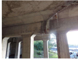
13. SE Pier cap.JPG
