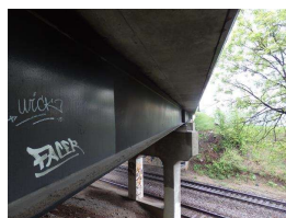
22. E. side fascia beam.JPG
