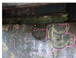
27. S. abutment E. side.JPG
