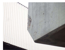
29. SW pier cap.JPG
