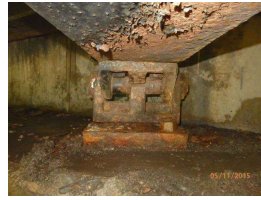
8. bearing N.abut - 3 beamline_2.JPG
