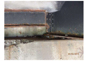
15. steel beam 3 - SE corner.JPG
