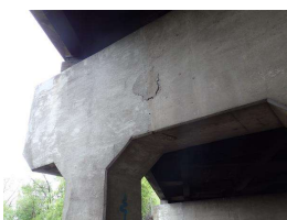
26. NE pier cap.JPG
