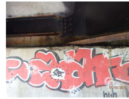
14. steel beam 2 - SE corner.JPG
