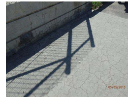
19. walk cracking.JPG
