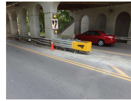
14. 002 New attenuator install - W.side.JPG
