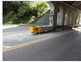
13. 001 New attenuator install - W.side.JPG
