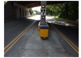
15. 003 New attenuator install - W.side.JPG
