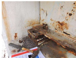
22. NW abut bearing anchor bolt 001.JPG
