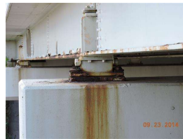
23. NE pier 2 bearing 014.JPG
