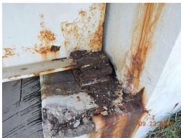
21. NE abut bearing anchor bolt 007.JPG
