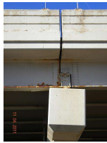
12. pier N.side joint_2.jpg
