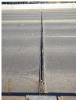
11. pier N.side joint_1.jpg
