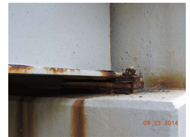
25. SW abut bearing anchor bolt 032.JPG
