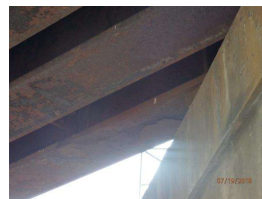
29. E Girder, S end (1).JPG
