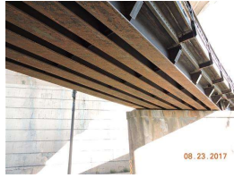
17. beams - under side.JPG
