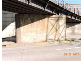
18. center pier wall.JPG
