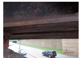
30. E Girder, S end (2).JPG
