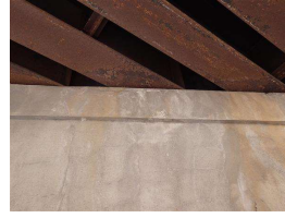
9. N side of center Pier cap (2).JPG
