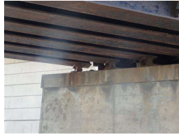
12. SE end of E Girder (1).JPG
