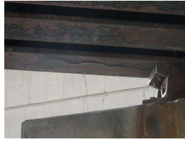
13. SE end of E Girder (2).JPG
