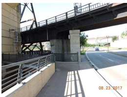
26. S. side abutment.JPG
