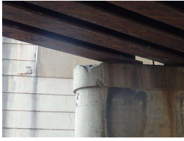
11. NE end of center Pier cap.JPG
