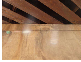
8. N side of center Pier cap (1).JPG
