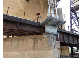
14. SW end of W Girder.JPG
