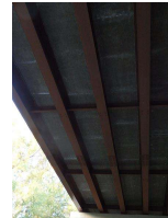
24. S side, mid span.JPG
