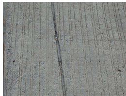
23. Poured joint at W end.JPG
