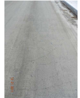
40. deck cracking_16-2.jpg
