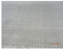
23. deck cracking_2-3.jpg
