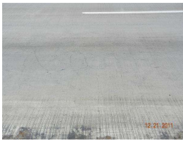
36. deck cracking_15-2.jpg
