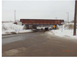
2. 2014 elevation view 014.JPG
