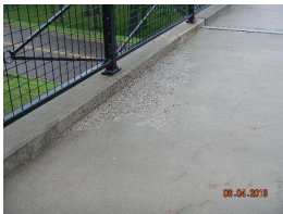
21. deck W.side scaling.JPG
