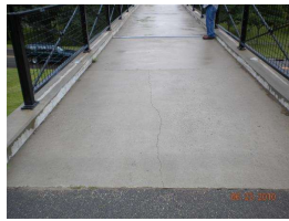
2. 6-23-2010_approach crack.JPG
