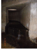
42. pipe and MH E.side_2.jpg
