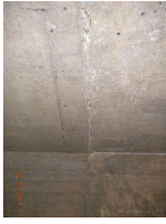
6. construction joint_1-2.jpg
