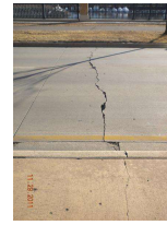
14. crack E.side_1.jpg
