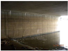
36. outlet drop E.side_2.jpg
