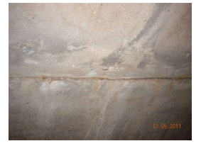
10. construction joint_2-2.jpg
