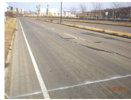
19. cracks WB_6.jpg
