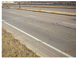
18. cracks WB_5.jpg
