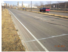
17. cracks WB_4.jpg
