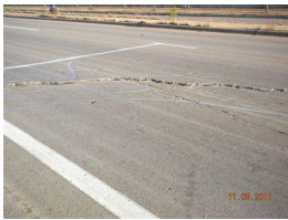
21. cracks WB_8.jpg
