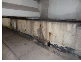
7. South abutment 1.JPG
