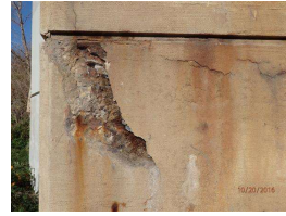
39. W Abutment, S end.JPG
