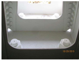
26. 012 Pier 2 South End.jpg
