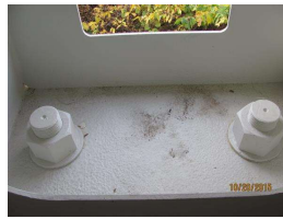
27. 013 Pier 2 South End.jpg
