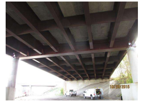
15. JMF003 Pier 2 Steel Cap.jpg
