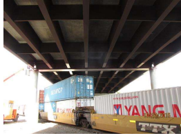
6. JMF005 Pier 1 Steel Cap.jpg
