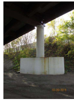
2. JMF006 Pier 2 S Column.jpg
