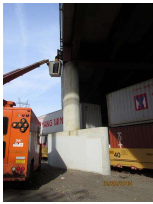
1. JMF002 Pier 1 S Column.jpg
