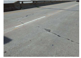
55. E Approach slab.JPG
