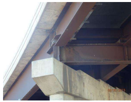
33. steel hinge assembly.JPG
