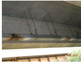
23. drain corrosion_2.jpg
