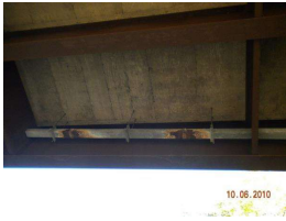
26. drain corrosion_4.jpg
