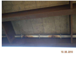
28. drain corrosion_5.jpg
