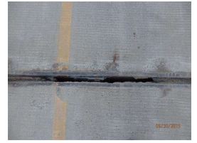
25. section #8 strip seal.JPG
