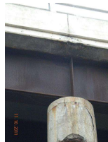
22. piercap N.end spall_2.jpg
