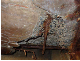
31. W abutment (1).JPG
