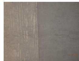
29. Underdeck, W end (1)..JPG
