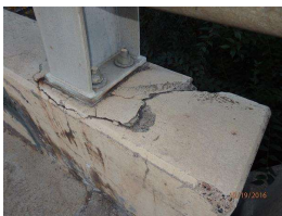
21. Concrete rail, E end..JPG
