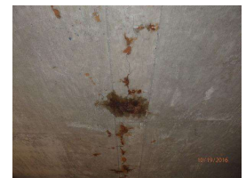
30. Underdeck, W end (2)..JPG
