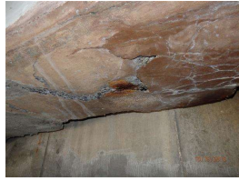
32. W abutment (2).JPG
