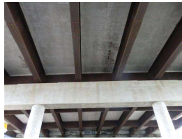
27. Center bay S end.JPG
