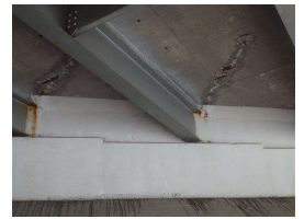
5. N end of bridge.JPG
