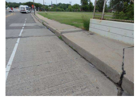
10. NE gutter line.JPG
