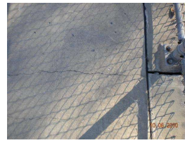
24. ramp cracks_1.jpg
