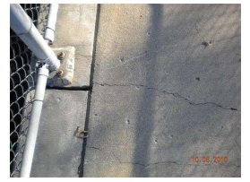
25. ramp cracks_2.jpg
