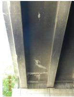
12. underdeck gutterline west_10.jpg
