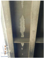
11. underdeck gutterline west_9.jpg
