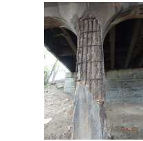
14. pier 2 - column W.side.JPG
