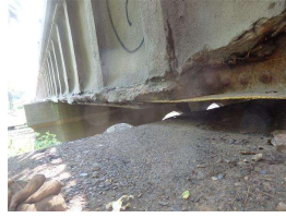
7. abut NE fascia beam.JPG
