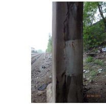
12. pier 2 - column E.side.JPG
