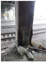
11. pier 2 - column E.inner.side.JPG
