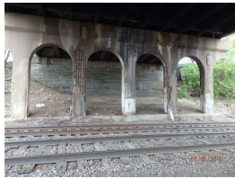
16. pier 2 - columns N.side.JPG
