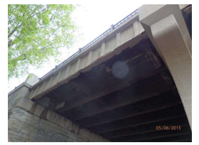
5. abut beam - NW.end.JPG
