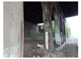
15. pier 2 - columns East view.JPG
