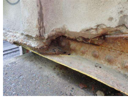
8. abut NE fascia beam (2).JPG
