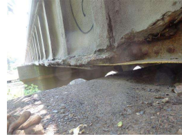
9. abut NE fascia beam.JPG
