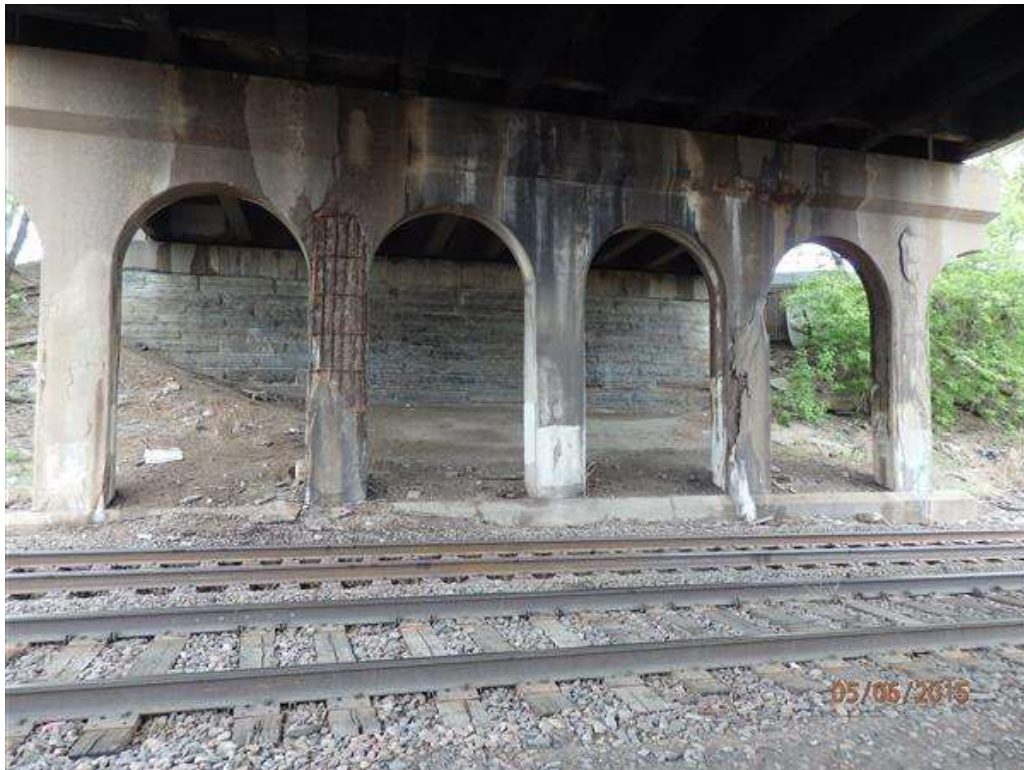
Photo 16 - pier 2 - columns N.side
