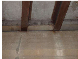
23. Diaphragm at pier 4 (1).JPG
