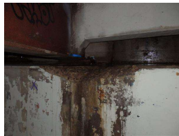
28. S Abutment, W end.JPG
