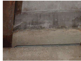
24. Diaphragm at pier 4 (2).JPG
