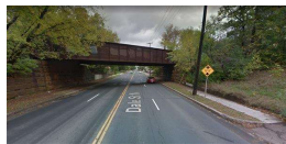
23. NB elevation warning signage.PNG
