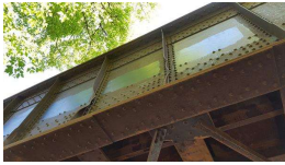
6. N girder over SB lane.jpg
