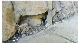
2. E abut drain pipe.jpg
