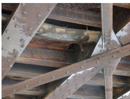
21. rain gutter brackets.JPG
