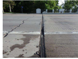
34. W approach, facing N.JPG
