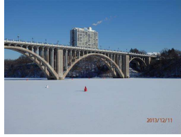
37. Elevation view - E. River Span.JPG
