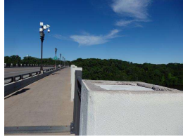
8. Concrete rail (2).JPG
