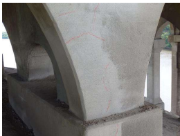
26. Span 9-10, Facing N, spandrel F.JPG
