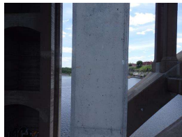
27. Span 9-10, Spandrel A looking S.JPG
