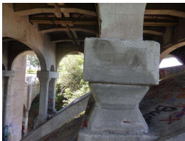
21. Span 6-7, Spandrel N, B looking S.JPG
