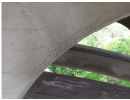
1. 017-concrete arch Unit 8a-g, ss.jpg
