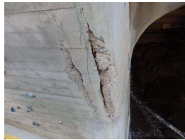
17. Span 6-7, N rib looking N (1).JPG
