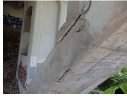
32. Span 10-11, N rib looking N (3).JPG
