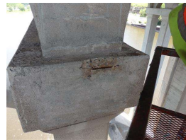
24. Span 8-9, Spandrel P cap.JPG
