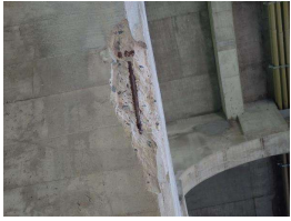
31. Span 10-11, N rib looking N (2).JPG
