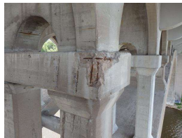
28. Span 9-10, Spandrel C looking S.JPG
