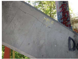
18. Span 6-7, N rib looking N (2).JPG
