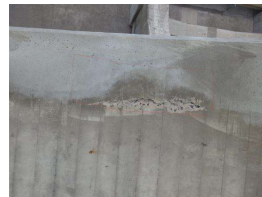
29. Span 10-11, N rib bottom.JPG
