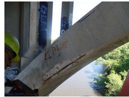
19. Span 6-7, N rib looking N (3).JPG
